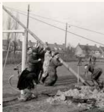
Aanleg eerste verlichting in 1962
